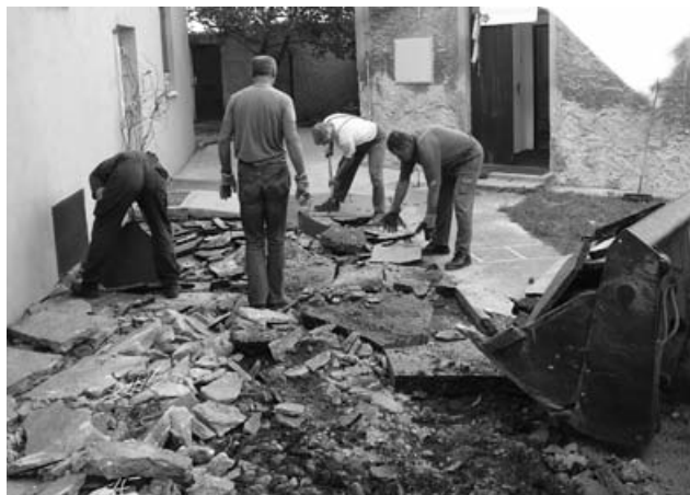
Radikální úpravy v MŠ u kostela, místo nevzhledného asfaltu bude trávník. Zajišťují technické služby.
