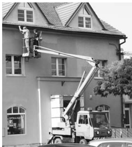
Měníme vzhled Městského úřadu, pan Toman se při nátěru budovy řádně zapotil. Patří mu dík za dobře odvedenou práci.
