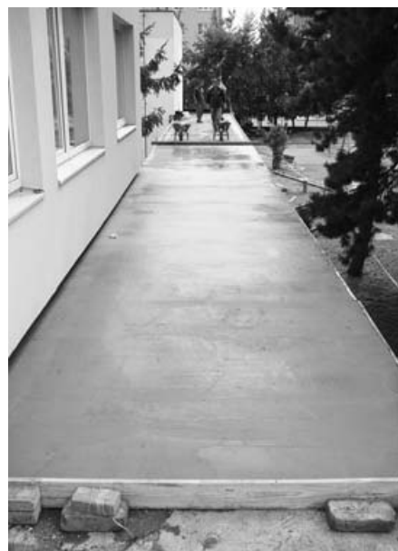
Zastřešení chodníků v areálu mateřské školy bylo v havarijním stavu, proto vedení města rozhodlo o rekonstrukci. Je nutné sejmout starou a již nefunkční izolaci, plochy vyspádovat betonem a vše nově zaizolovat a oplechovat. Opravy realizujeme prostřednictvím technických služeb města, čímž ušetříme zhruba 80 tisíc korun.
