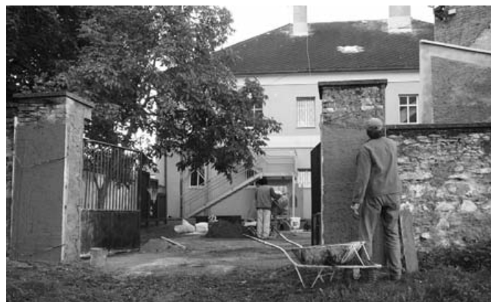
Pan Toman a pan Pohlodko při opravách rozpadlé zdi v MŠ u kostela. Na opravě této zdi, první po 33 letech, technické služby pracovaly o prázdninách, spotřebovaly při ní 25 tun písku.
