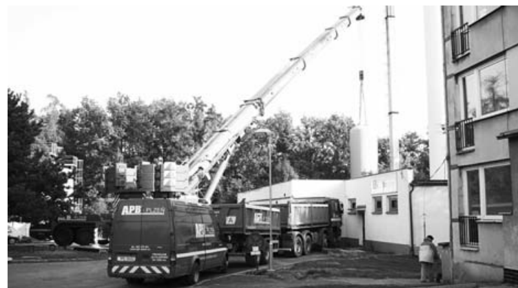
Instalace nových nádrží rekuperační jednotky prováděná s pomocí jeřábu. Pro zajímavost pár technických údajů: jedna nádrž váží 15 tun, jeřáb váží 170 tun a jeho maximální nosnost je 350 tun.
