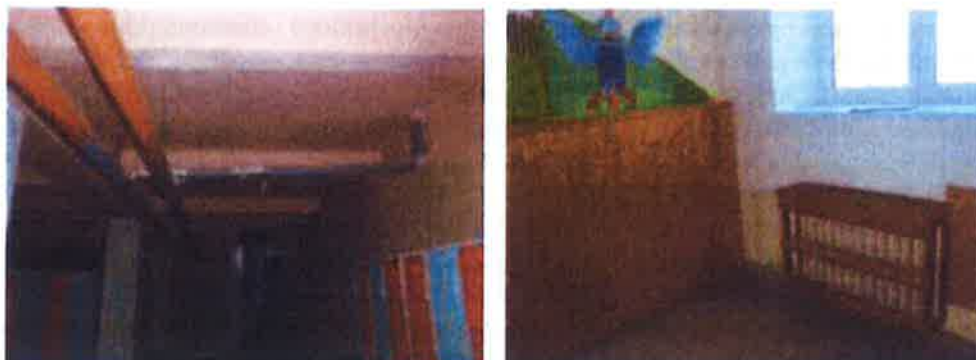
Obr. 6 – Chybné napojení tří topných těles na okruh 6. větve pro CRITTALL
